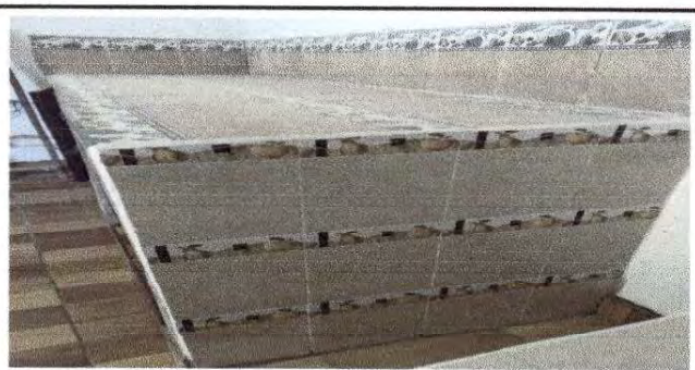
Foto 12 : Sustrucción de azulejo en gabinete de cocina.
