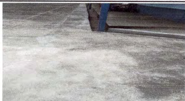
Foto 19: Reparación de planchas de concreto en el patio.
