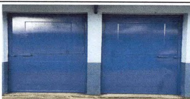
Foto 24: Pintura de dos puertas de servicios sanitarios.
