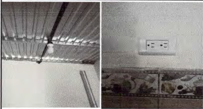
Foto 9 Sustrucción del sistema electrico en el área de la cocina.
