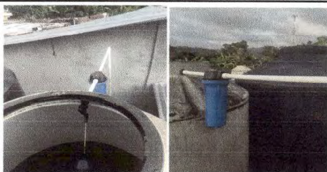
Foto 15: Sustitución de accesorios en depósitos de agua.
