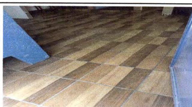
Foto 4: Sustrucción de piso de cemento por piso cerámico en la cocina.
