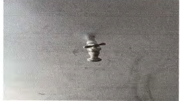
Foto 8: Sustrucción de tubería de la línea principal de agua potable de la cocina.
