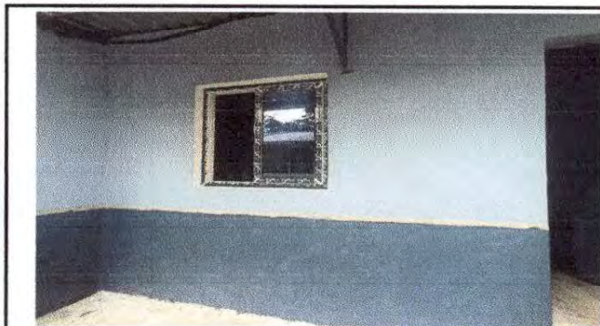
Foto 3: Ampliación y sustitución de ventana en la cocina del establecimiento.
