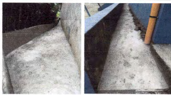
Foto 18: Se realizó la reparación de la cuneta de concreto en la parte de atrás de las aulas de párvulos y cocina.
