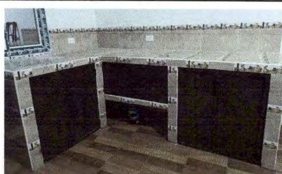
Foto 22: Colocación de puertas de metal en el gabinete de cocina.
