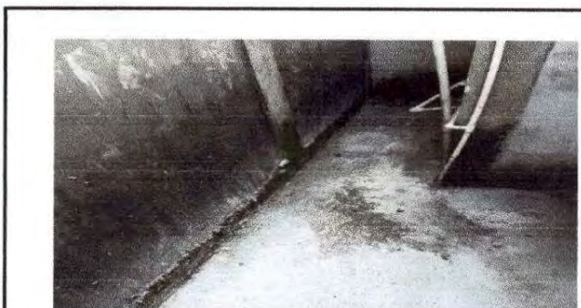
Foto 5: Reparación de la banqueta de concreto en la parte de atrás de los baños.
