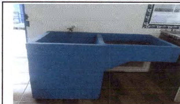
Foto: 13 Instalación de pila de cemento en la cocina escolar.
