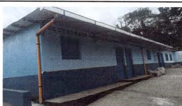
Foto 16: Sustitución de canal de metal, por canal galvanizado y bajadas de agua en el módulo de párvulos y cocina.
