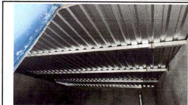
Foto1: Sustrucción de lámina, por lámina troquelada aluzinc calibre 26 en la cocina.
