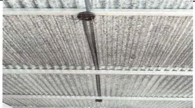
Foto 10: Sustrucción del cableado electrico en el módulo aulas.
