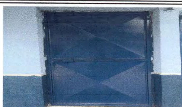
Foto 2: Sustrucción de puerta de metal en la cocina del establecimiento.
