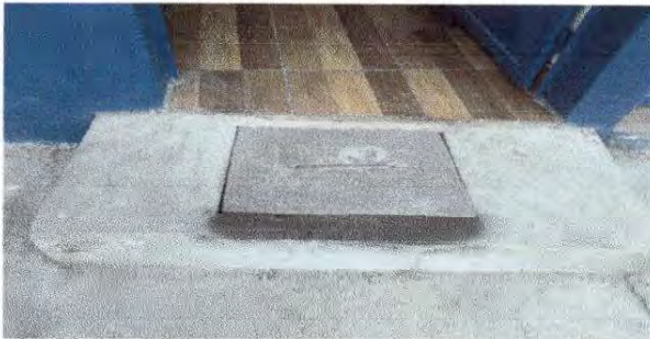
Foto7: Sustrucción de caja de registro de aguas residuales en la cocina.
